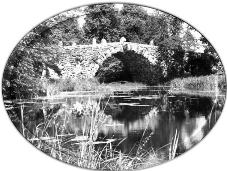
Большой валунный мост в усадьбе Василево
