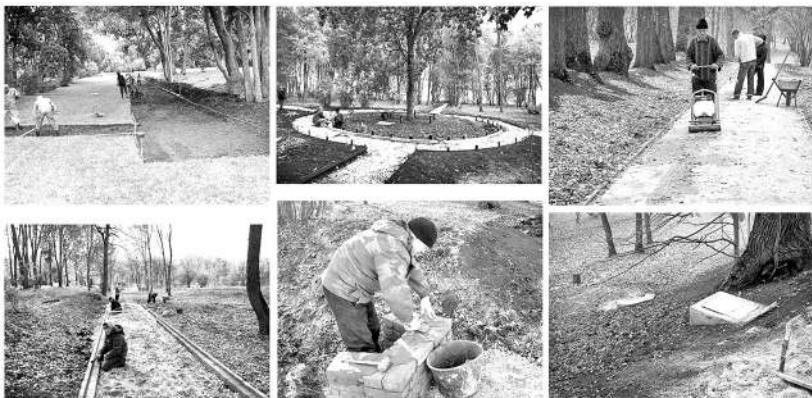
Реставрационные работы второго этапа (2008 год)
