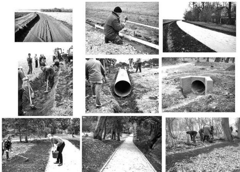
Реставрационные работы третьего этапа (2009 год)
