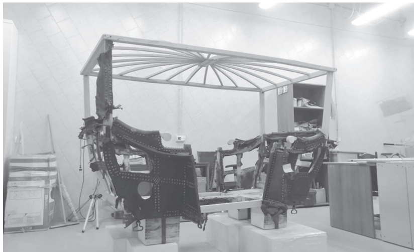
Реконструкция крыши кузова
