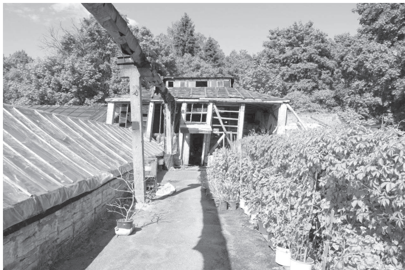
Состояние оранжереи перед реставрацией. Июнь 2017 года
