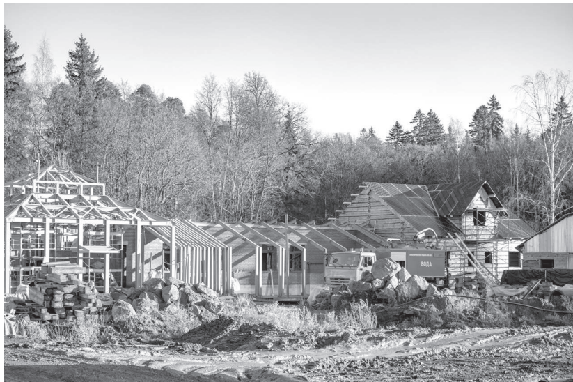
Строительство зимнего сада. Октябрь 2020 года
