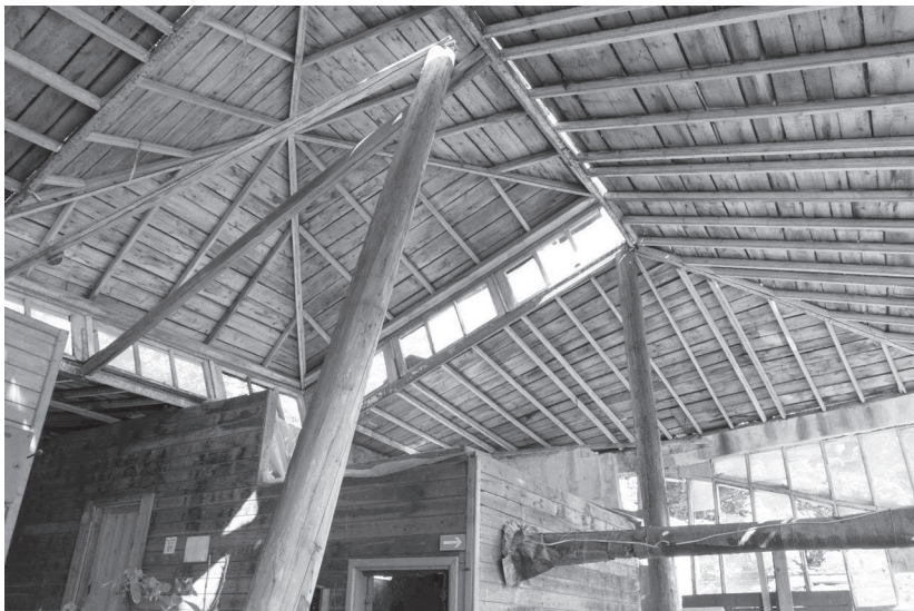
Центральный павильон оранжереи. Июнь 2017 года
