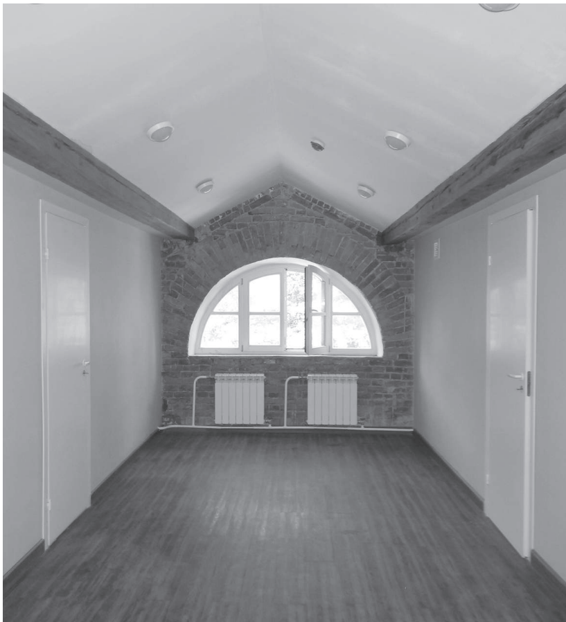
Мансарда, устроенная в чердачном пространстве флигеля по проекту приспособления. Июнь 2021 года
