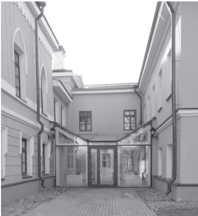
Остекленный переход между основным зданием и флигелем. Апрель 2022 года
