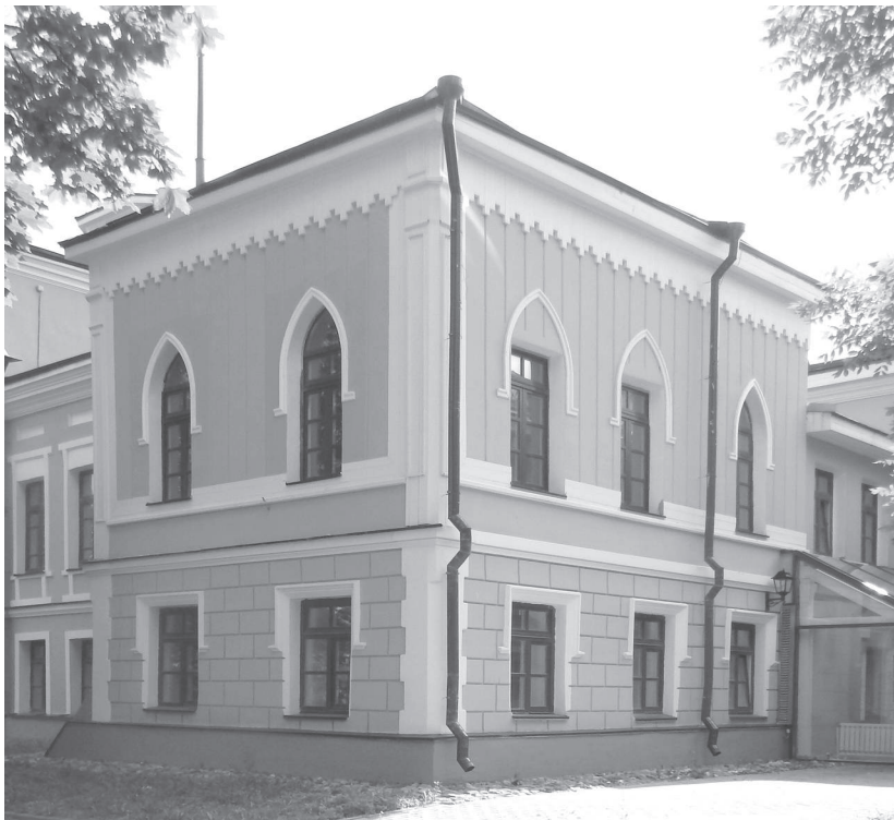
Общий вид юго-западной пристройки после реставрации. Июль 2021 года
