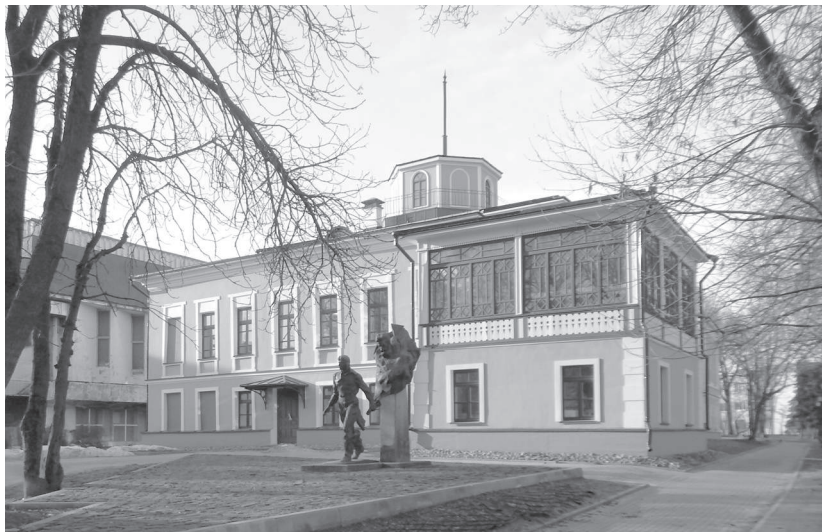
Общий вид памятника по завершении реставрационных работ. Апрель 2022 года
