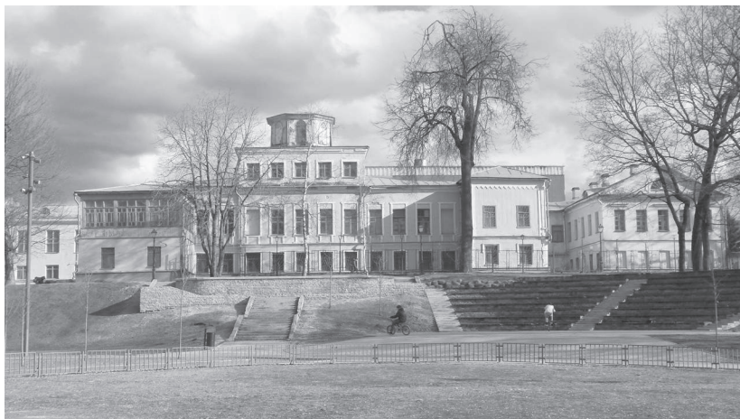
Общий вид памятника до начала реставрационных работ. Март 2017 года
