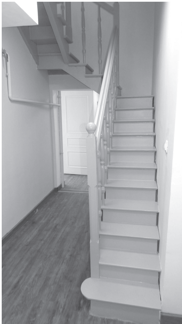
Деревянная лестница из мезонина в бельведер. Вид после реставрации. Июнь 2021 года
