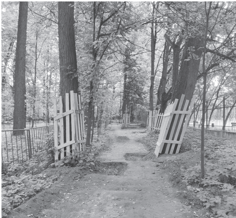
Окапывание корней старовозрастных деревьев в полотне дороги перед откапыванием дорожного корыта малой механизацией. Июнь 2023 года
