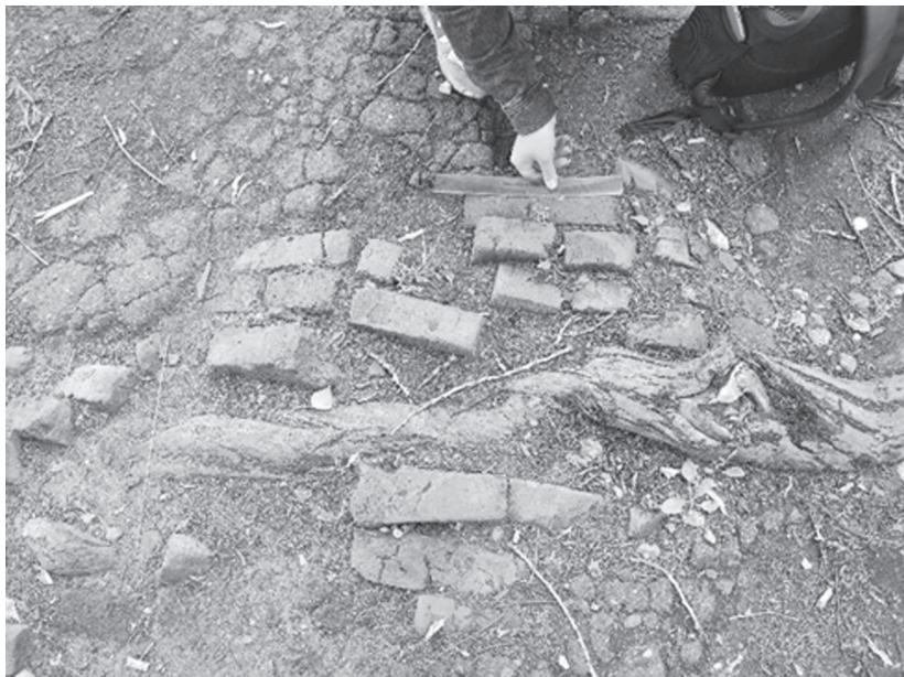
Старинное кирпичное покрытие бывшего Елового проспекта под слоем асфальта. 2022 год
