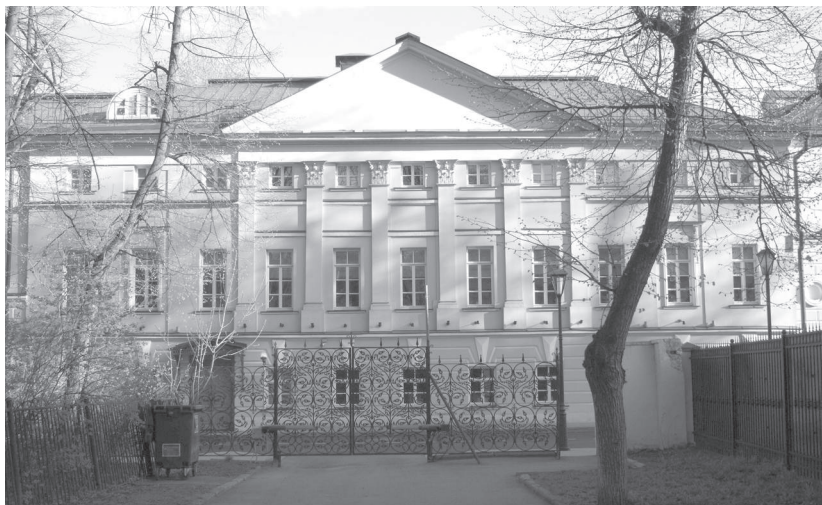
Ил. 8. «Рабочий дом» (бывший «новый», или «красный» дом Юсуповых). Северный фасад
